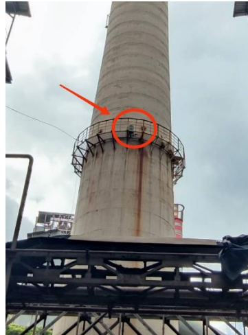
รูปที่ 3-21 ระบบตรวจวัดฝุ่นอัตโนมัติ (CEMs)
